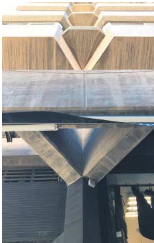
Detalle de los pilares de hormigón visto del Edificio Goya.
