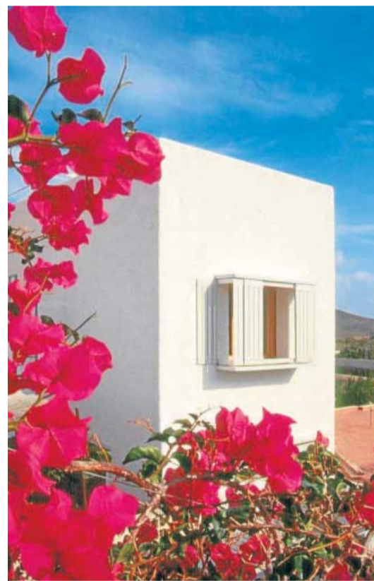
Vista exterior de la construcción.
